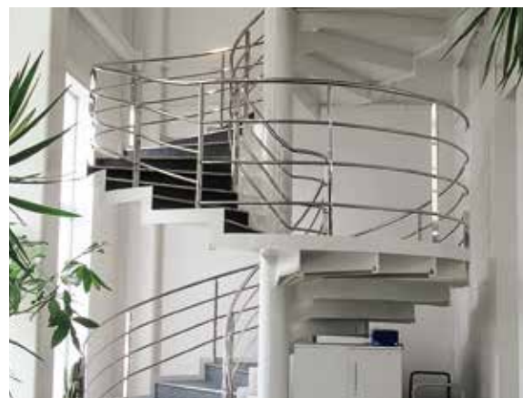
社内の螺旋階段（ベルテクネ製の手すり）
