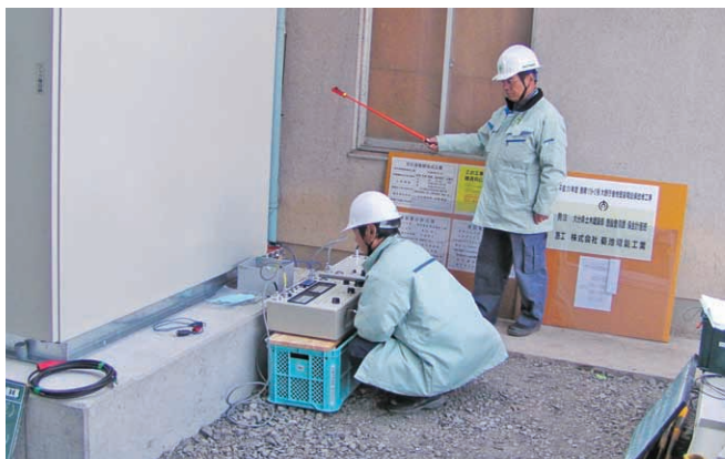
高圧受電設備の保守点検（測定作業）。
