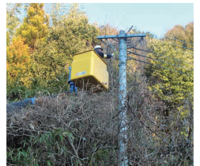
高所作業車を利用した作業。
