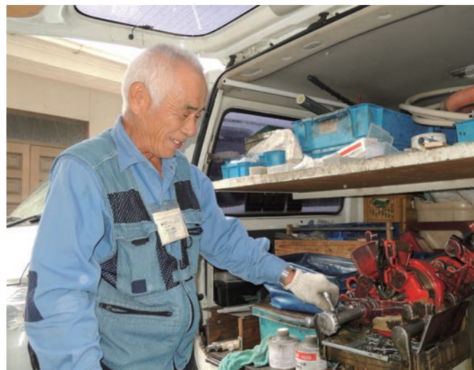
ガス管の切断作業
